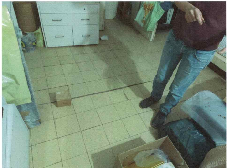
תמונה 4. שקיעת מרצפות משמעותית מעל קו הסדק בתקרה.
