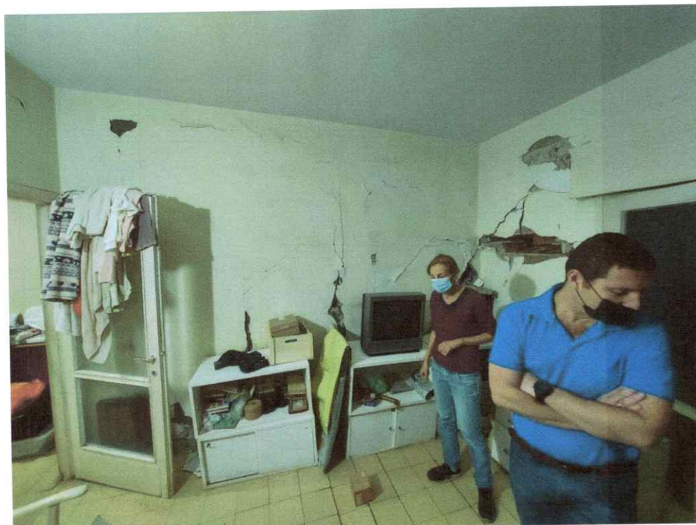
תמונה 6. שבר משמעותי בקירות הדירה מעל גן הילדים. שנבע משקיעת השלד ולחץ על הקירות.
