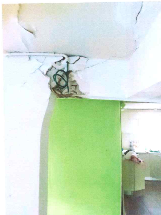
תמונה 5. גזירת קורת בטון, בתקרת גן ילדים, זיון שעבר דפורמציה, סדקים מאוד משמעותיים בקורה ובתקרה. מצביע על מסוכנות גבוהה.
