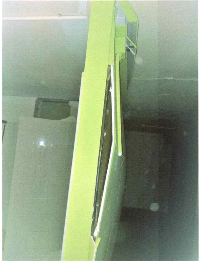
תמונה 3. סדק משמעותי בתחתית תקרה . באזור שקיעת המרצפות שבתמונה 4.
